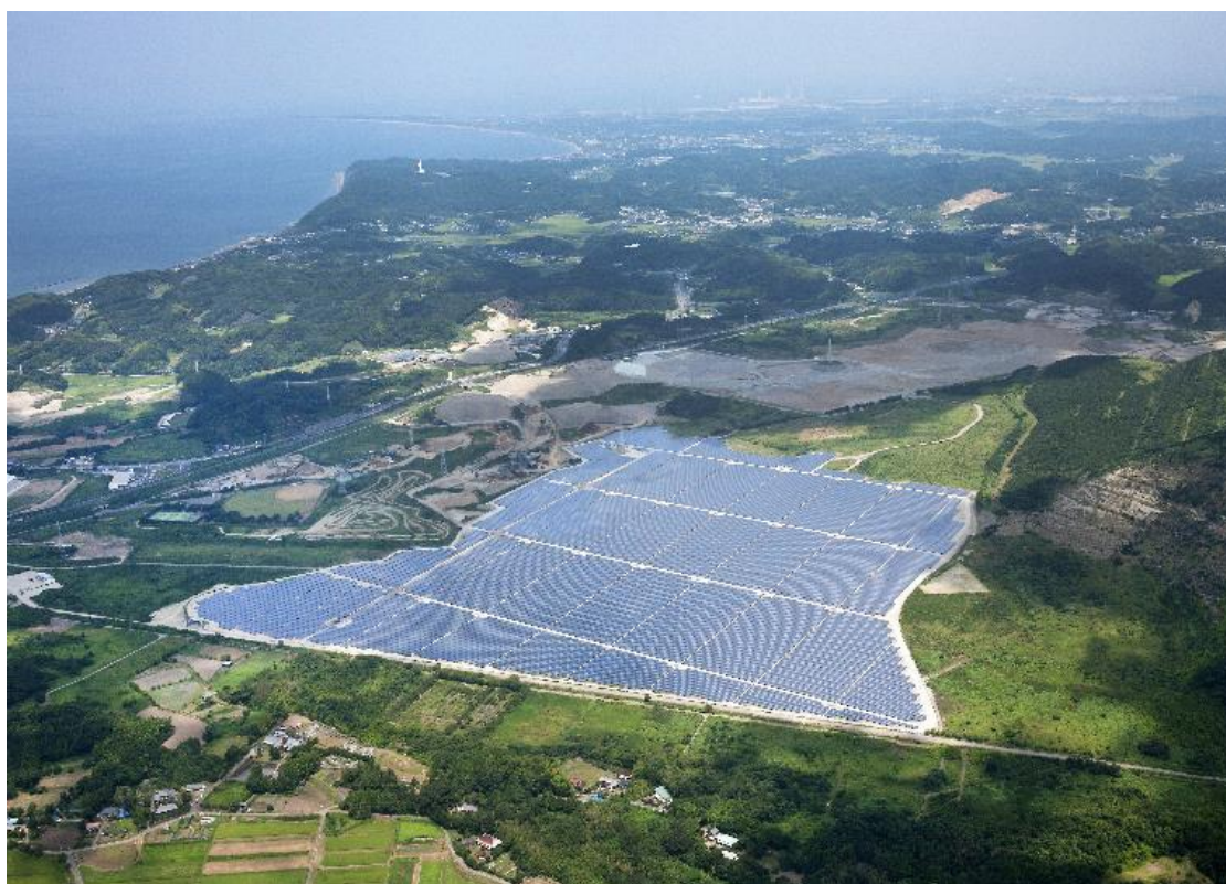
（富津ソーラー発電所 全容）
